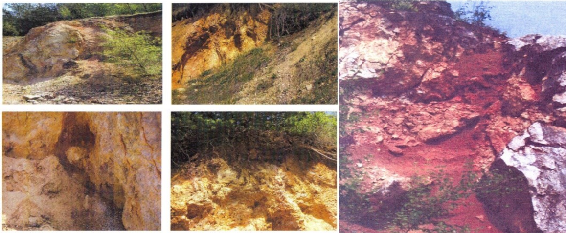
Obr. 12 V detailnom zábere (vľavo) zvetrávanie wettersteinských vápencov a dolomitov v Kečove
